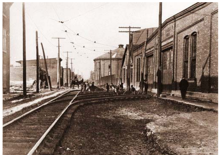
Travaux sur les voies de tramway donnant accès aux ateliers sur la rue du Havre, du côté nord de la rue Sainte-Catherine en 1912.
