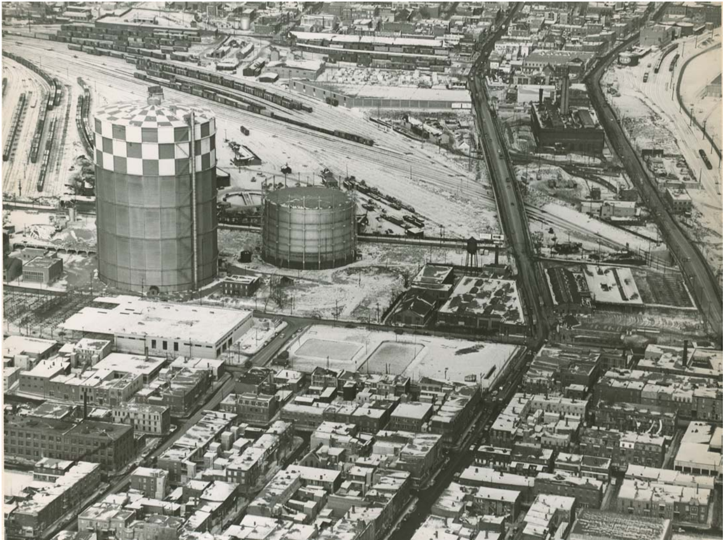
Vue aérienne en 1956. À gauche, face à l'imposant réservoir de la compagnie du gaz, la première partie du garage d'autobus Frontenac est en construction. À droite, les remises de tramways en voie de démolition et plus loin vers l'est la centrale d'électricité.
